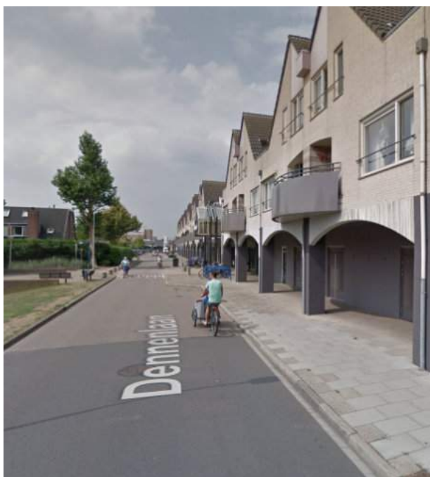
woningen aan Dennenlaan
